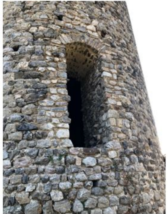
Après les travaux (porte de la Tour)
