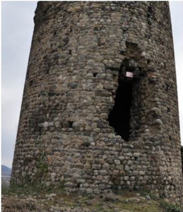
Avant les travaux (porte de la Tour)
